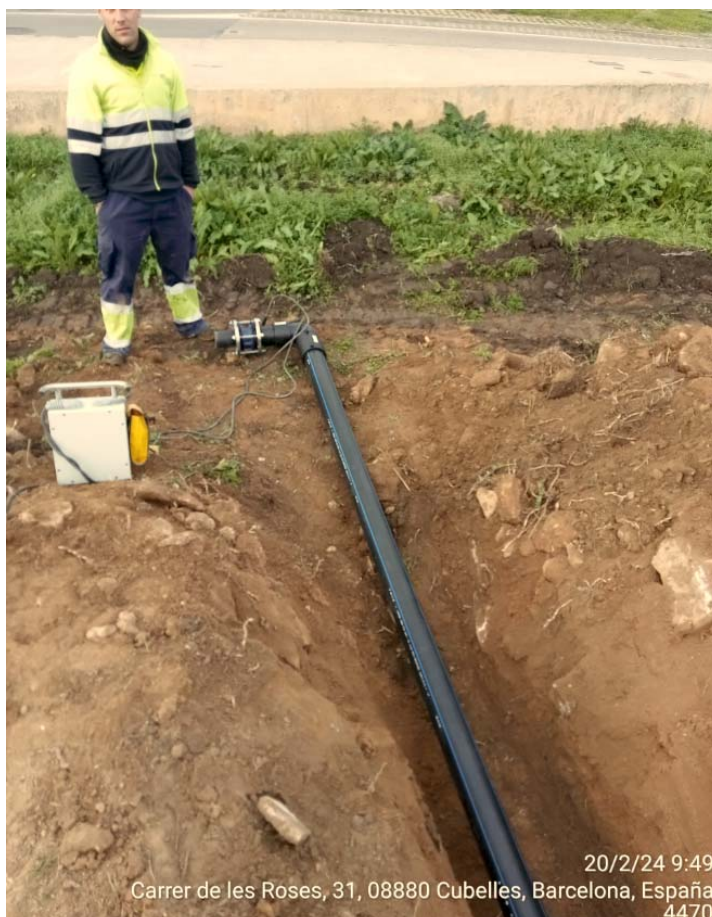
Imatge en fase d'obra
