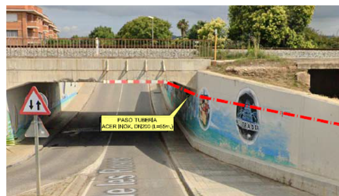
TRANSVERSAL ESTADO ACTUAL EN PASO BAJO VÍAS RENFE
