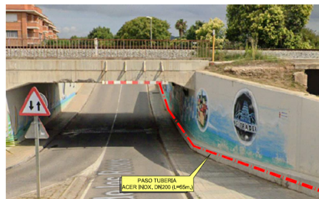
TRANSVERSAL ESTADO ACTUAL EN PASO BAJO VÍAS RENFE
